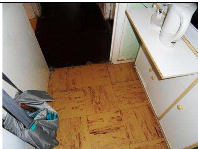
005 - Appartements - Cuisine LOT 0002 PH12 : Dalle, colle, ragréage PRE012
