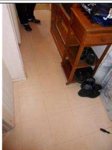
016 - Appartements - Entrée LOT 0102 PH13 : dalles PRE013
